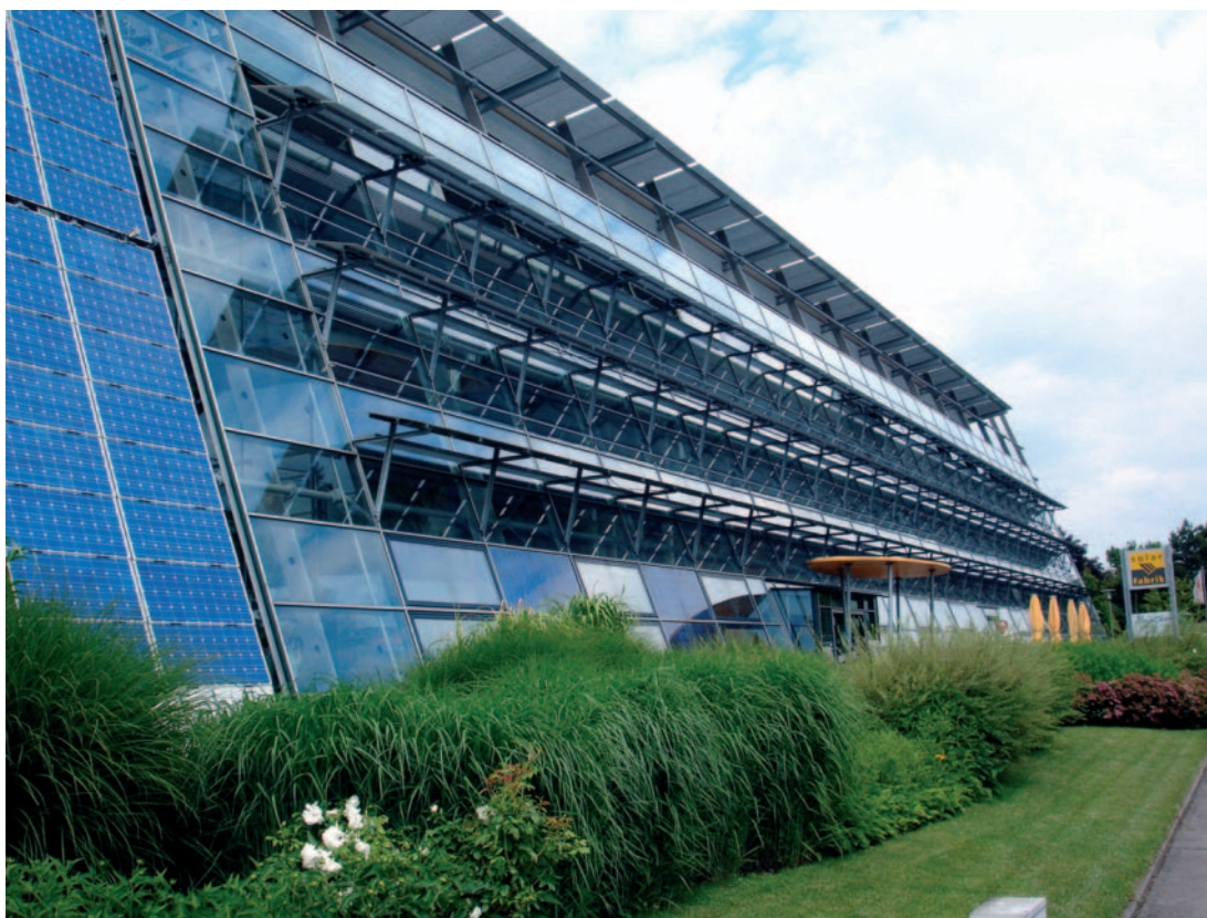
Solar-fabrik - Usine de panneaux photovoltaïques - Freiburg, Allemagne
