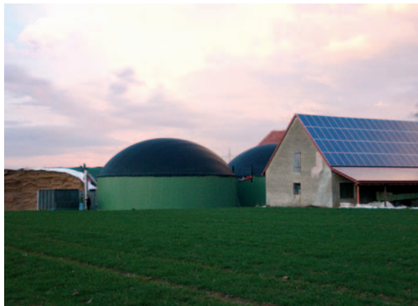
Méthanisation à la ferme, Allemagne
